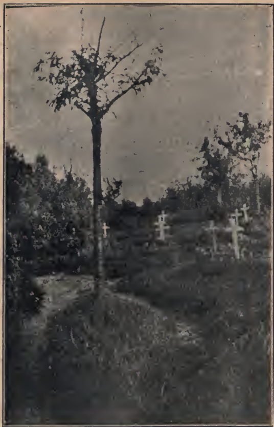
Cemitério entre a 2. a linha e a linha de apoio. Neuve-Chapelle.
